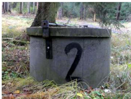
Vrty napájející vodovod užitkovou vodou
