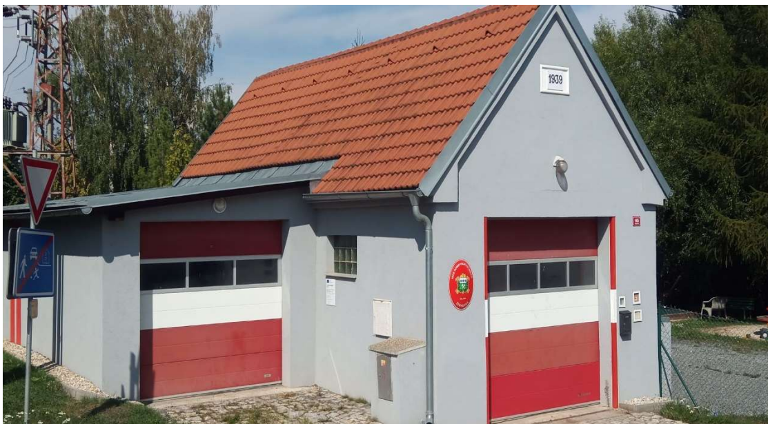
Obrázek 44 Objekt sboru dobrovolných hasičů-zbrojnice
