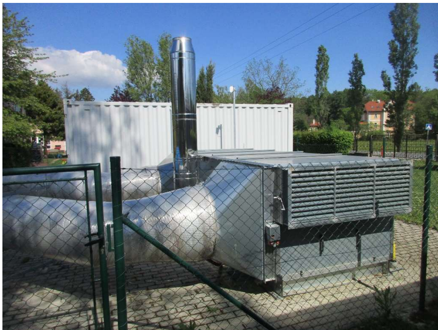
Obrázek 35 Objekt ZŠ Mukařov-přetlaková hala (agregát)
