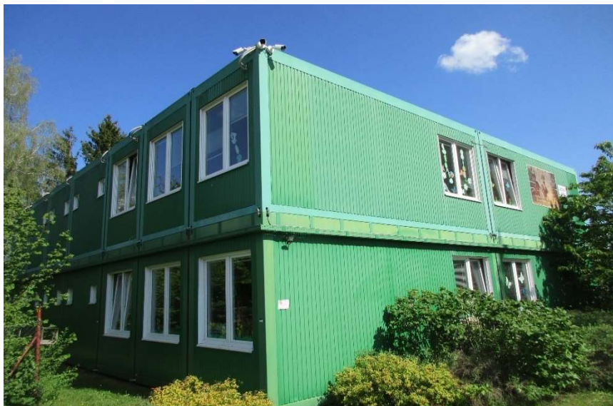
Obrázek 30 Objekt ZŠ Mukařov-kontejnerová přístavba
